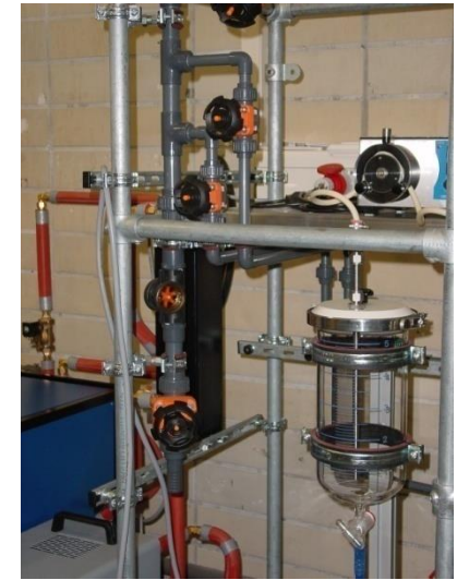
Kühlwasserleitung/ Cooling water pipe
