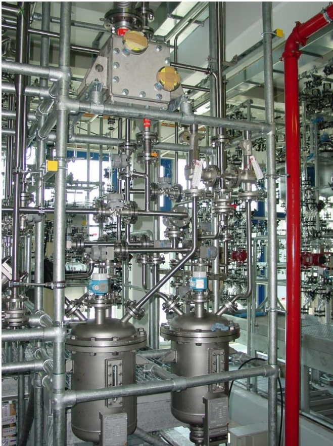
Kondenstor mit Dest.-Vorlage Condenser with Dist. Receiver
