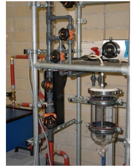
Kühlwasserleitung/ Cooling water pipe
