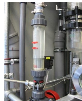
Schwabekörper- Durchflussmesser mit Min.-Signal / flow meter with min. signal
